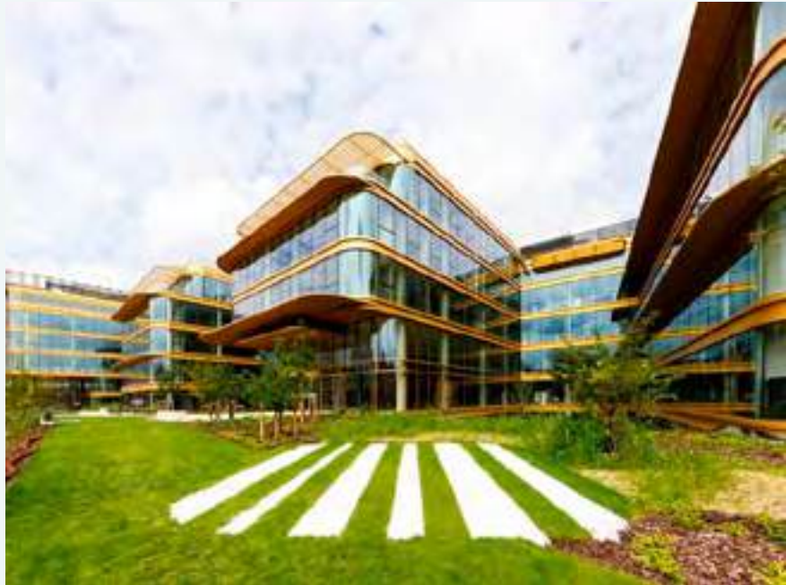
1. Immeubles de bureaux Sakura Myr Muratet
