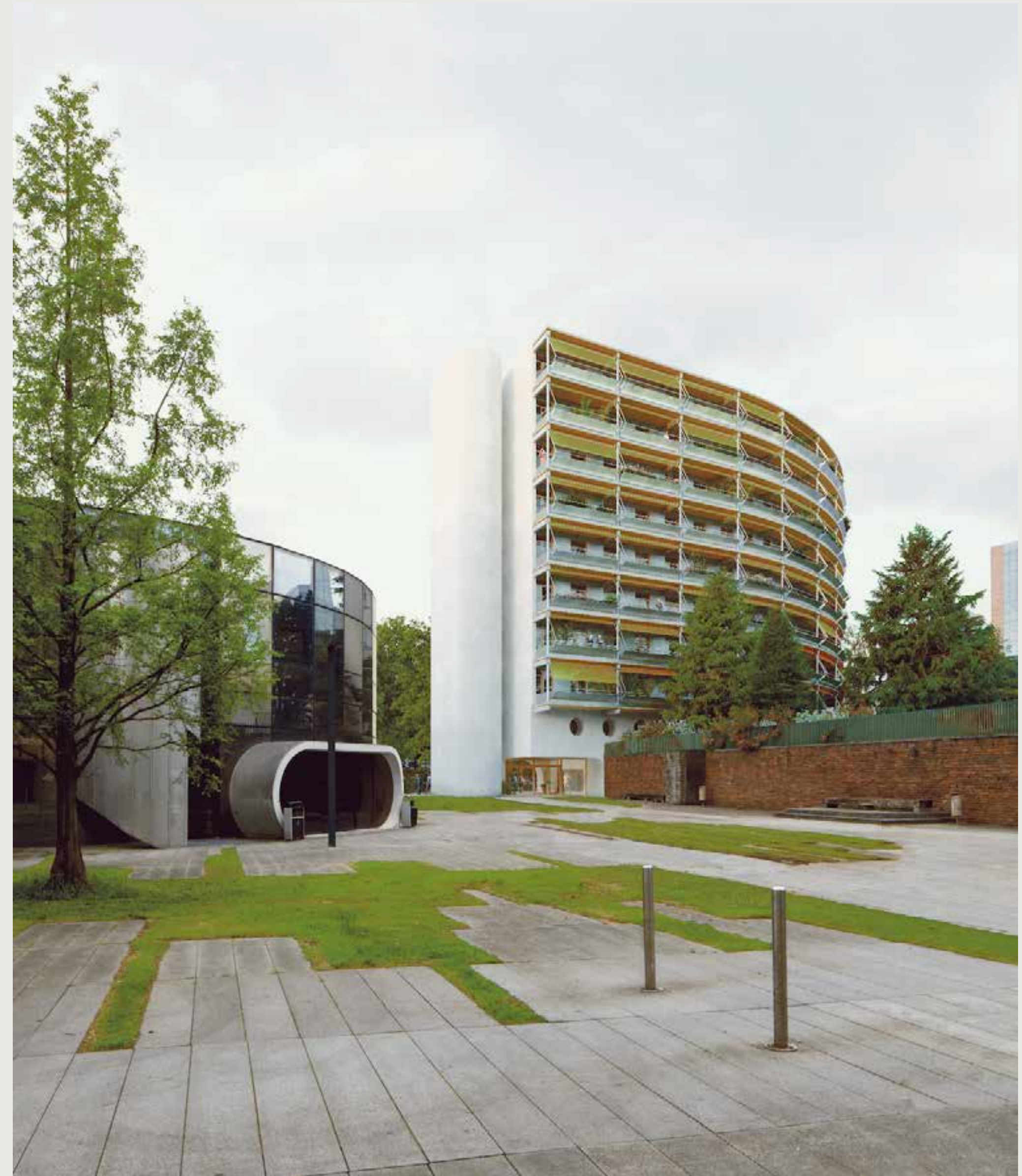
Façades sud Niemeyer © NRAU
