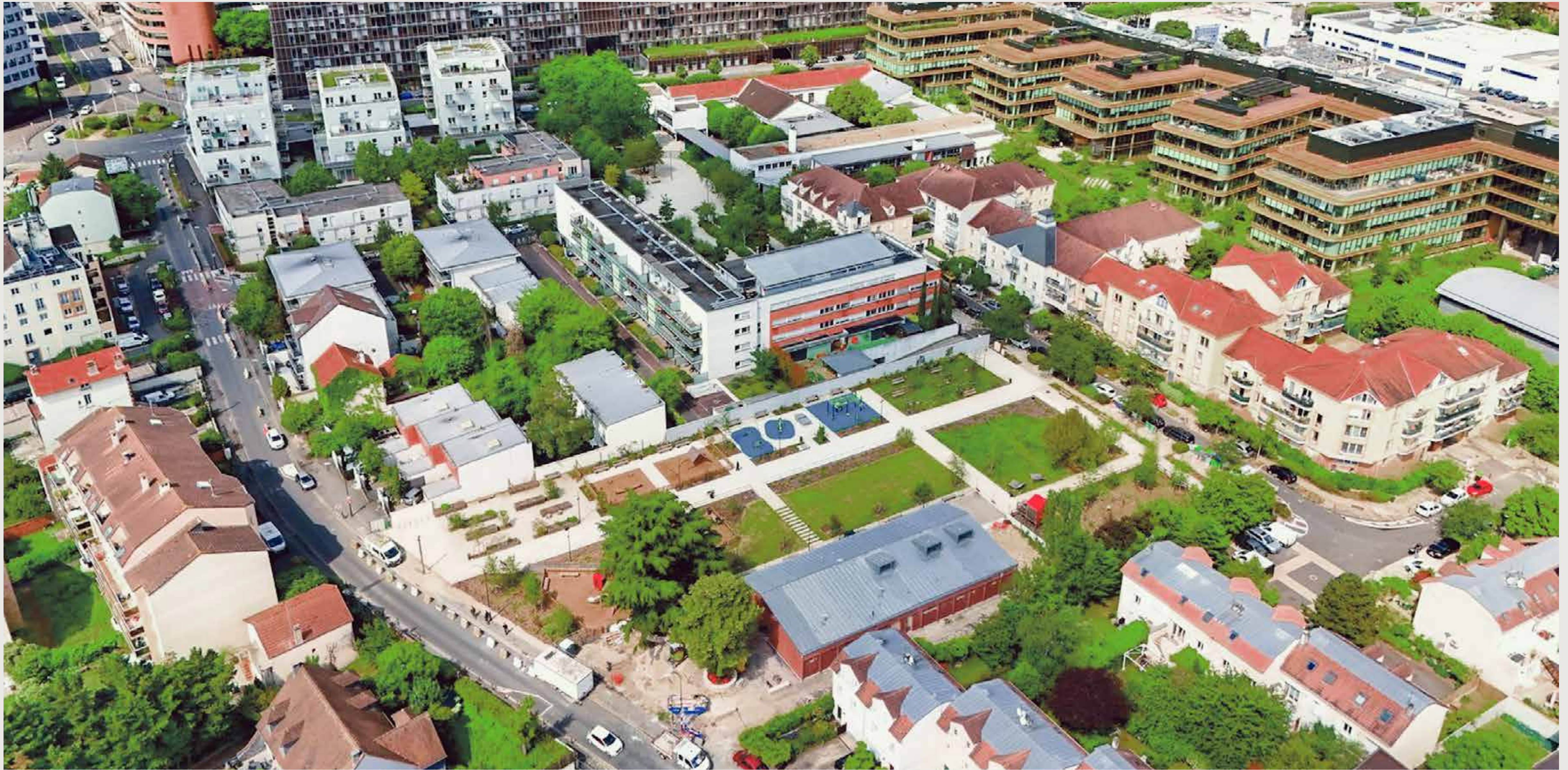
Le nouveau parc urbain Dulcie September et l'ensemble des espaces publics réalisés dans le cadre de l'opération d'aménagement Tassigny-Auroux à Fontenay-sous-Bois © Agence 22 degrés
